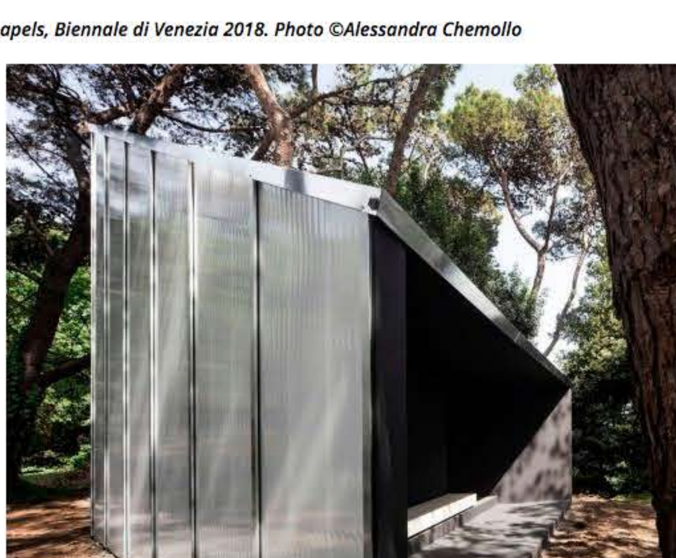
Una forma precisa di origini anonime, Andrew Berman con Moretti e Terno. "La struttura è una forma precisa di origini anonime, una presenza indefinita nel paesaggio. Il portico è un luogo per incontrarsi, dal quale osservare verso l'esterno e guardare quanto vi è intorno. La panca offre una seduta dalla quale guardare verso l'interno, dalla luce verso l'oscurità".
